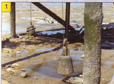
1 - Le MO1 est équipé de 2 grands carrelets équilibrés par de grosses gueuses servant de contrepoids.
