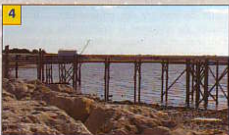
4 - Pour reconstruire ce ponton carrelet dévasté par une tempête, il ne faut pas moins d'une quarantaine de poteaux en bois (souvent d'anciens pylônes, supports des lignes téléphoniques) et creuser autant de trous de 1,20m à 1,50m de profondeur dans la banche. Les poteaux ne comportent pas d'ancrage ou de renfort béton d'une hauteur visible supérieure à 30 cm.
